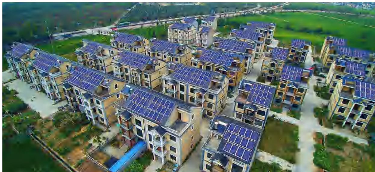
装机容量：3MWp 项目地点：衢州
