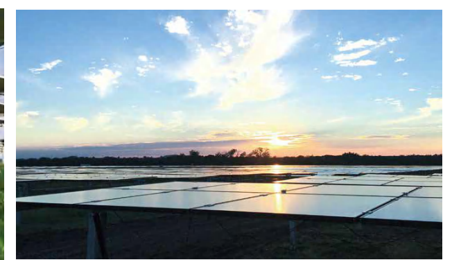
装机容量：200MWp 项目地点：美国德州 产品类型：帷联跟踪系统
