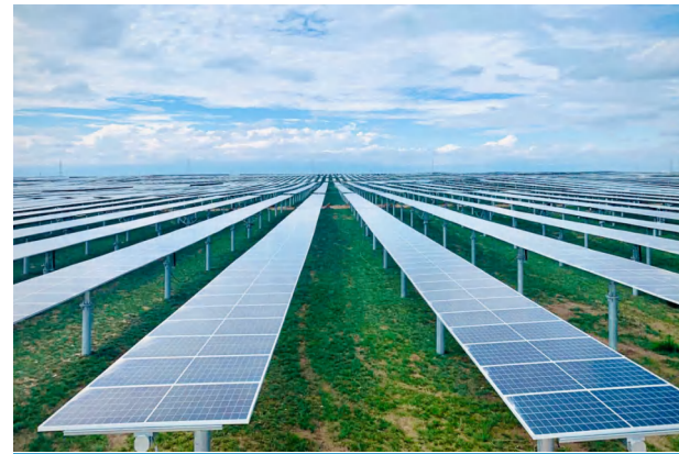
装机容量：460MWp 项目地点：青海共和 产品类型：帷屹跟踪系统
