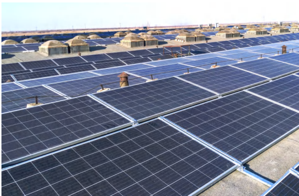
装机容量：3MWp 项目地点：河北沧州 产品类型：帷帘导流板屋顶系统
