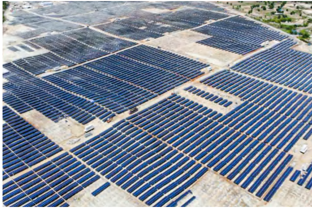
装机容量：50MWp 项目地点：越南 产品类型：地面固定式光伏支架系统
