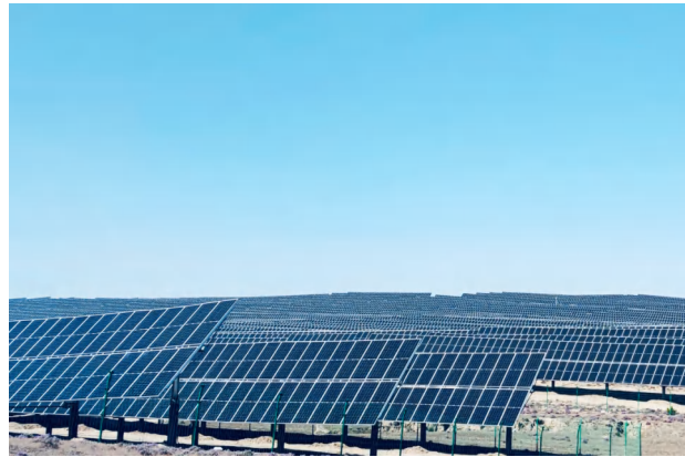
装机容量：150MWp 项目地点：宁夏中卫 产品类型：帷博跟踪系统
