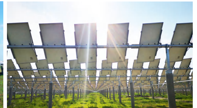
系统容量：100MWp 项目地点：吉林白城 产品类型：帷联跟踪系统
