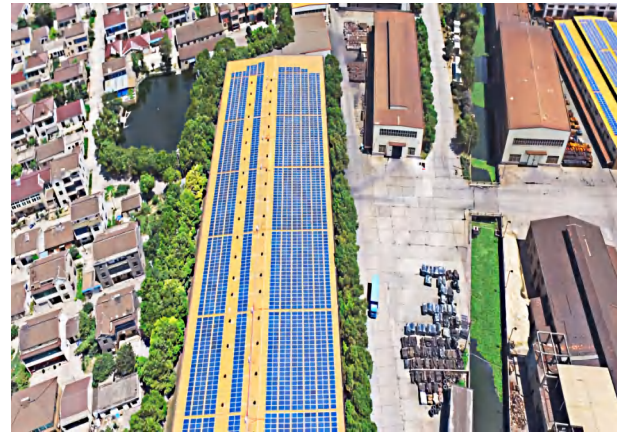
装机容量：21.5MWp 项目地点：江苏丹阳 产品类型：彩钢瓦屋顶系统
