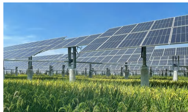
装机容量：150MWp 项目地点：浙江温州 产品类型：帷联跟踪系统
