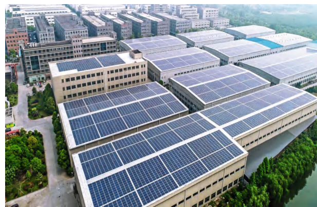
装机容量：6MWp 项目地点：浙江杭州 产品类型：帷帘BIPV屋顶系统
