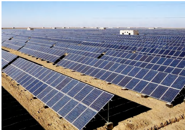
装机容量：200MWp 项目地点：甘肃敦煌 产品类型：地面固定式光伏支架系统
