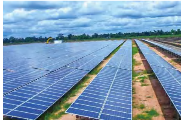
装机容量：60MWp 项目地点：泰国 产品类型：地面固定式光伏支架系统
